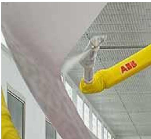
ILUSTRACIÓN20: APLICACIÓN DE REVESTIMIENTO. FUENTE: ABB
