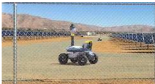
ILUSTRACIÓN 31: ROBOT AUTÓNOMO DE SMP ROBOTICS EN PLANTA FOTOVOLTAICA. FUENTE: SMP ROBOTICS
